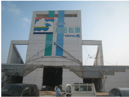
写真-1 道の駅 高田松原：最上階（6F）際まで津波がきたとのこと。
