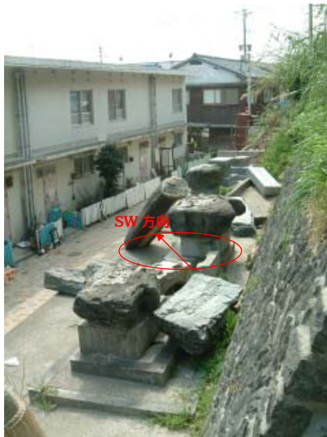
写真-4 小鷹神社の参道西側の石碑の転倒：3 本ともほぼ NE-SW 方向（水平円盤内の矢印）を向いている。
