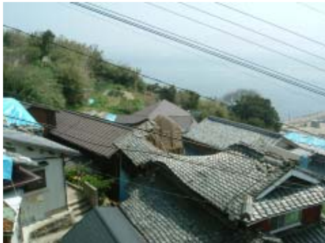
写真-17 よう壁の頂部がせり出したが、前の家の屋根で押さえられている。
