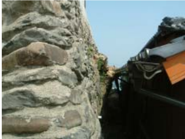
写真-17 よう壁の頂部がせり出したが、前の家の屋根で押さえられている。
