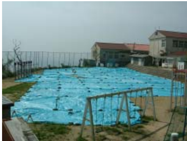
写真-15 玄海小学校の校庭：盛り切り境界でのすべりに伴う沈下の例と思われる。
