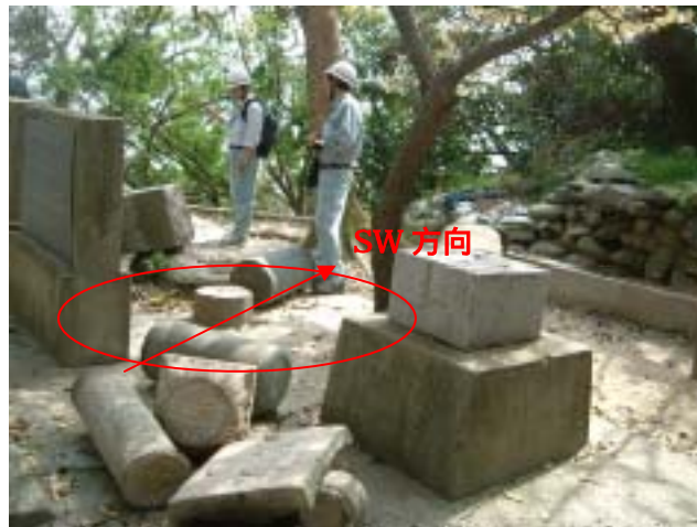
写真-3 小鷹神社境内の石碑類の転倒：すべてではないが、NE-SW 方向（水平円盤内の矢印）を向いているものが多い。
