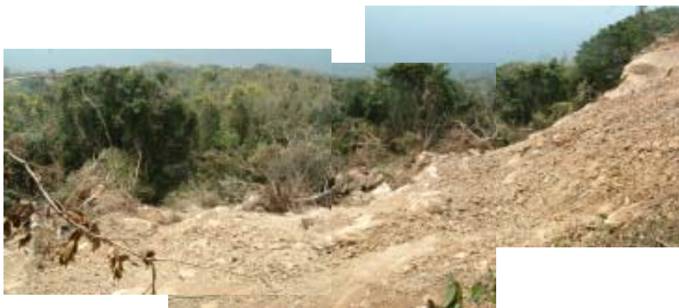
写真-9 風化した玄武岩層の地震による崩壊
