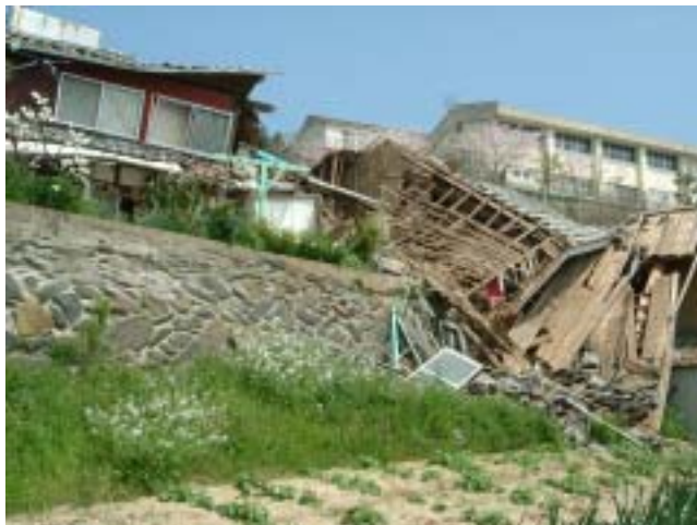
写真-18 屋根が梁ごと無くなった家屋：前に回って見ると、擁壁・宅地には問題なく、震動の被害のようだ。
