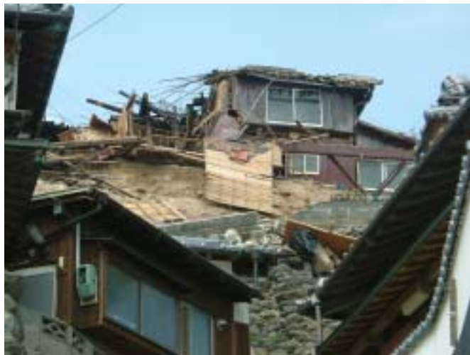
写真-13 手前側の土留めよう壁と宅地の一部が崩壊し、建物が崩壊したと思われる例。
